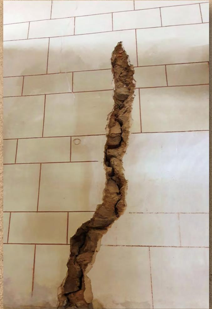
An der Rückwand der Kirche war im Bereich des Orgelgehäuses ein Riss entstanden. Hier drohten Teile von Putz und kleine Mauersteine die Orgel zu verunreinigen bzw. Teile dieser zu zerstören.
