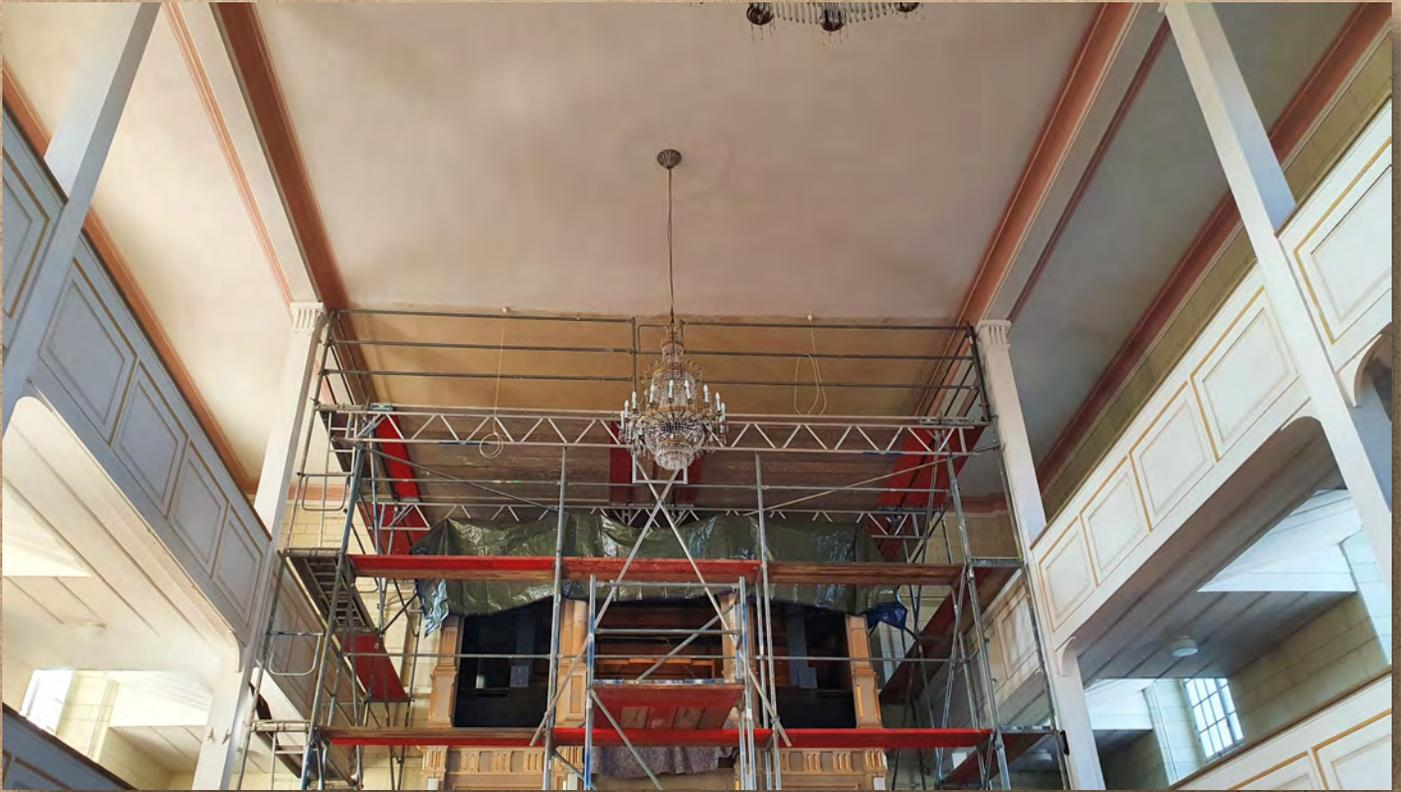
Nachdem der Deckenputz erneuert war, konnte dieser farblich der vorhandenen Decke angeglichen werden. Anschließend wurde dann auch das Gerüst wieder abgebaut.
