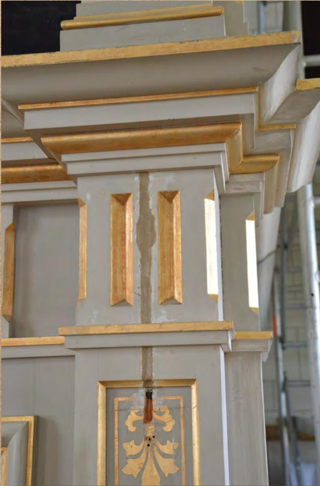
Am Orgelprospekt waren für daran angebrachte Lampen Kabelkanäle gestemmt bzw. gefräst worden und dann mit Kitt ausgefüllt.
