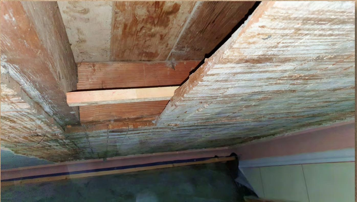
Zwischen Orgelgehäuse und Kirchendecke wird nun ein Arbeitsbereich eingerichtet, der mit Folien abgedichtet wird, damit der bei den Arbeiten entstehende Staub nicht in die Windladen der Orgel gelangt.
